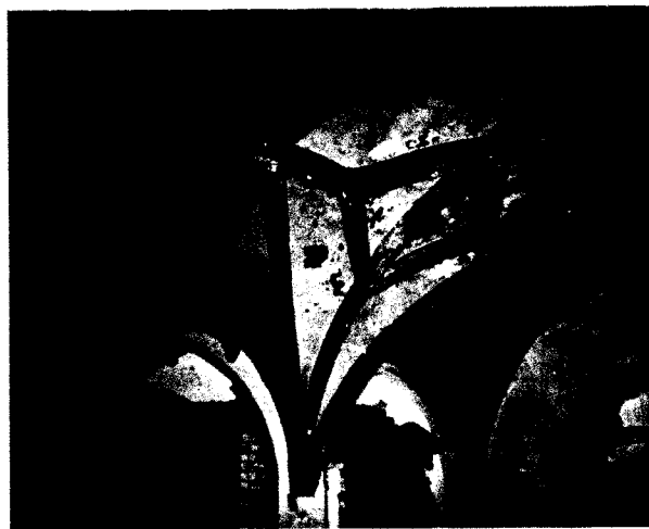
54. Innenansicht des gotischen Hauses Breite Straße 32 in Spandau, Zustand 1986.
