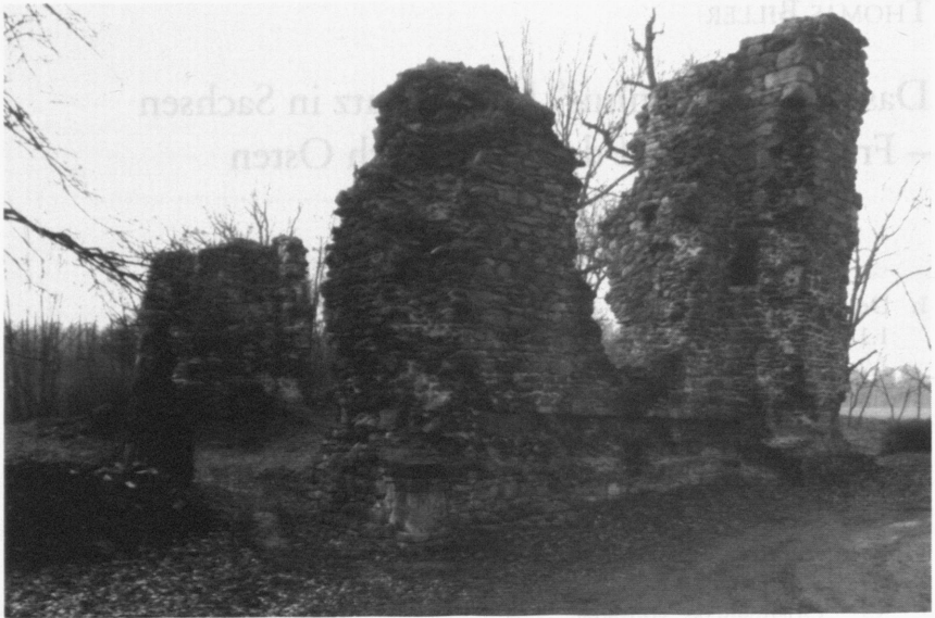
Abb. 1. „Wüstes Steynhus“ bei Oschatz, die Ruine von Osten, im Vordergrund der Osteckbau, mit Strebepfeiler und Wendeltreppe rechts, hinten die Reste des Südeckbaues
