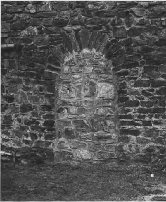
6. Niederburg Rüdesheim, vermauerte Pforte der Phase 1 in der Ringmauernordseite.
