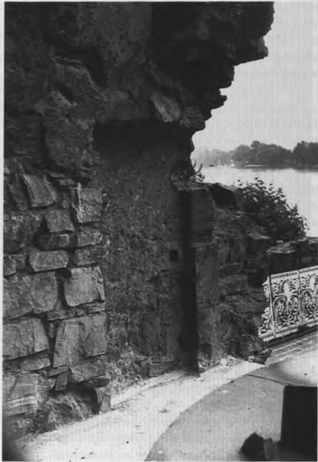
14. Niederburg Rüdesheim, Südende des Raumes 11 im 1. Obergeschoß, Ostwand mit Gewänderest der Pforte zur Treppe; bemerkenswert die Nische zum Aufschlagen der Tür, in ihr Ankerloch des Riegels und Ausbruchloch der Angel, jeweils in einen Quader gearbeitet.
