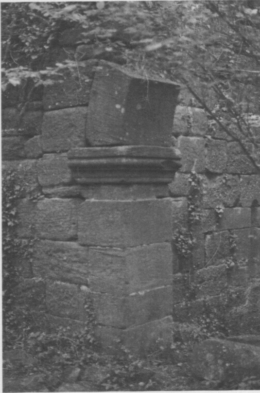
11. Girbaden, Ansatz eines rundbogigen Tores, außen an der Südostecke des Saalbaues; links dessen südliche Giebelwand, rechts die hofseitige Ostwand. Der Bogen schloß die säulengetragene Galerie ab, die dem Erdgeschoß des Saalbaues östlich vorgelagert war.
