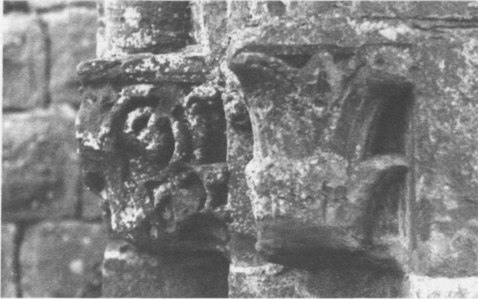
19. Girbaden, Kelchblockkapitell und Knospenkapitell am westlichen, äußeren Gewände des teilweise erhaltenen Fensters der Südwand des Saales
