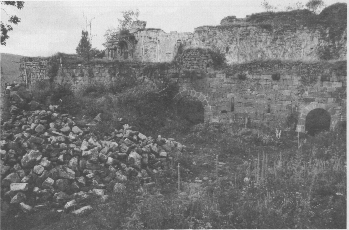
3. Girsbaden. Die Ruine des Saalbaues von Osten. Über den beiden Rundbogentoren die Kragsteinreihe von der Decke über der Säulengalerie, ganz links, über dem Gebüsch, der Ansatz des Rundbogentores (vgl. Abb. 12)
