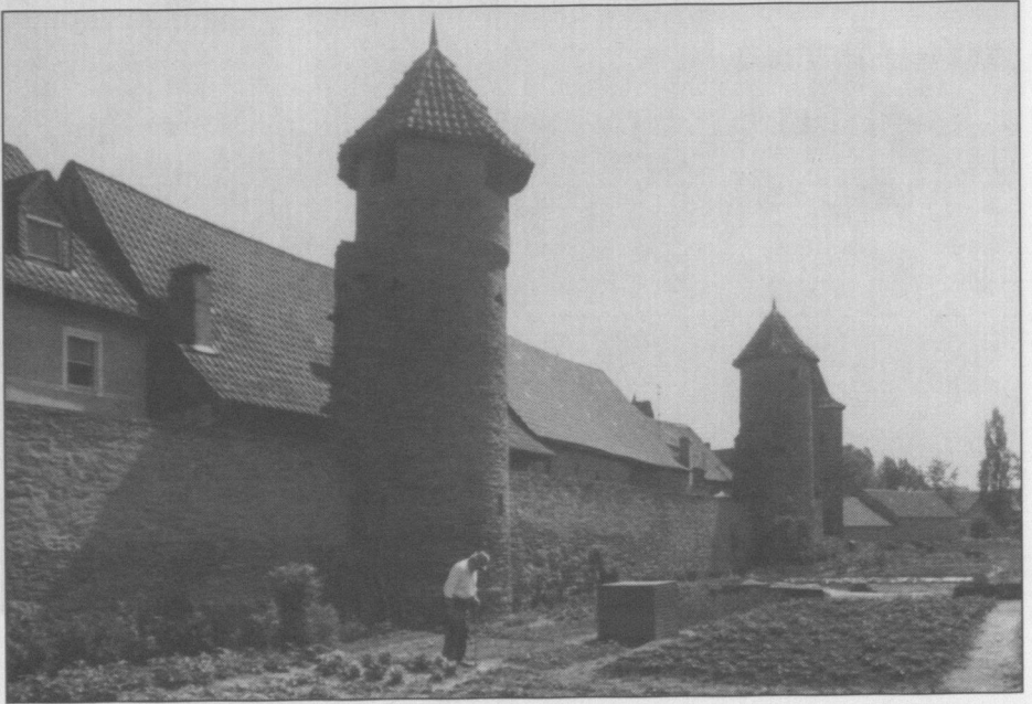
Abb. 5: Mainbernheim (Unterfranken), Südwestseite der Stadtbefestigung, nach 1382 Zwischen den sehr kleinen Türmen besaßen die Mauern keine Wehrgänge.
