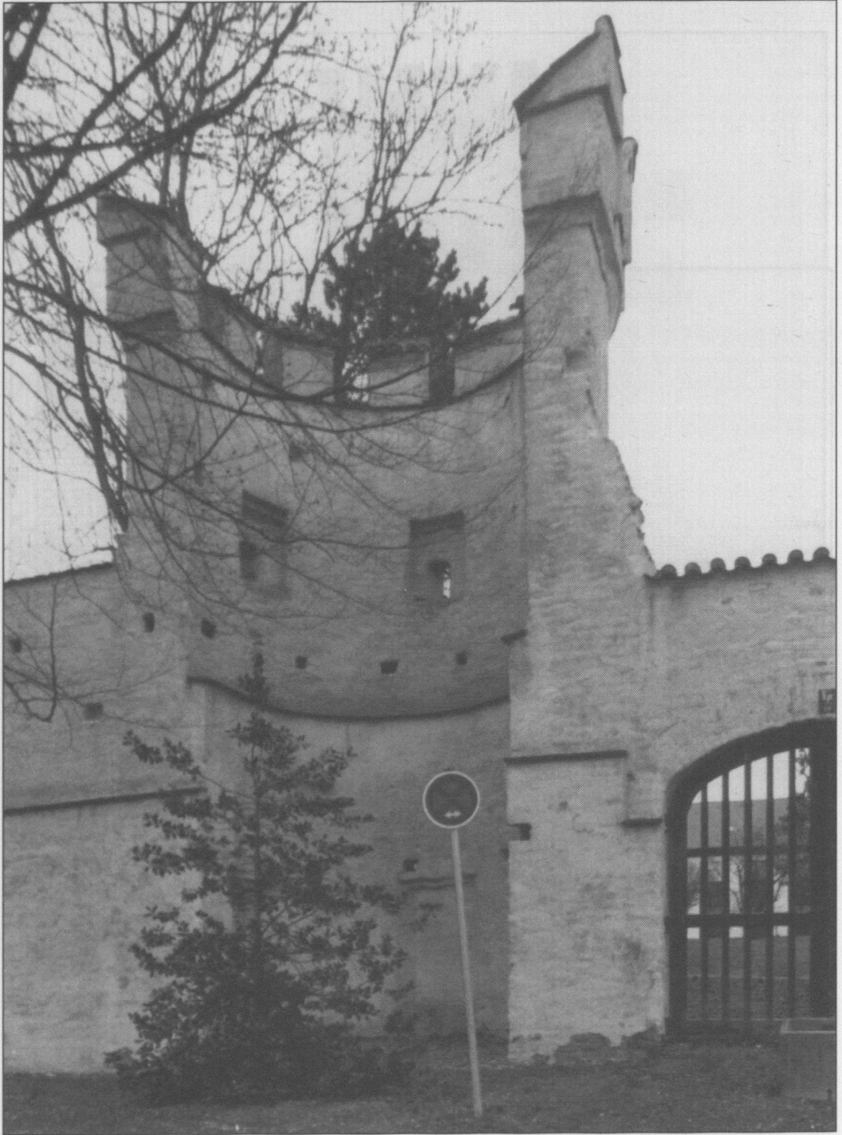
Abb. 11: Landsberg am Lech, Innenansicht eines Schalenturmes, um 1425
