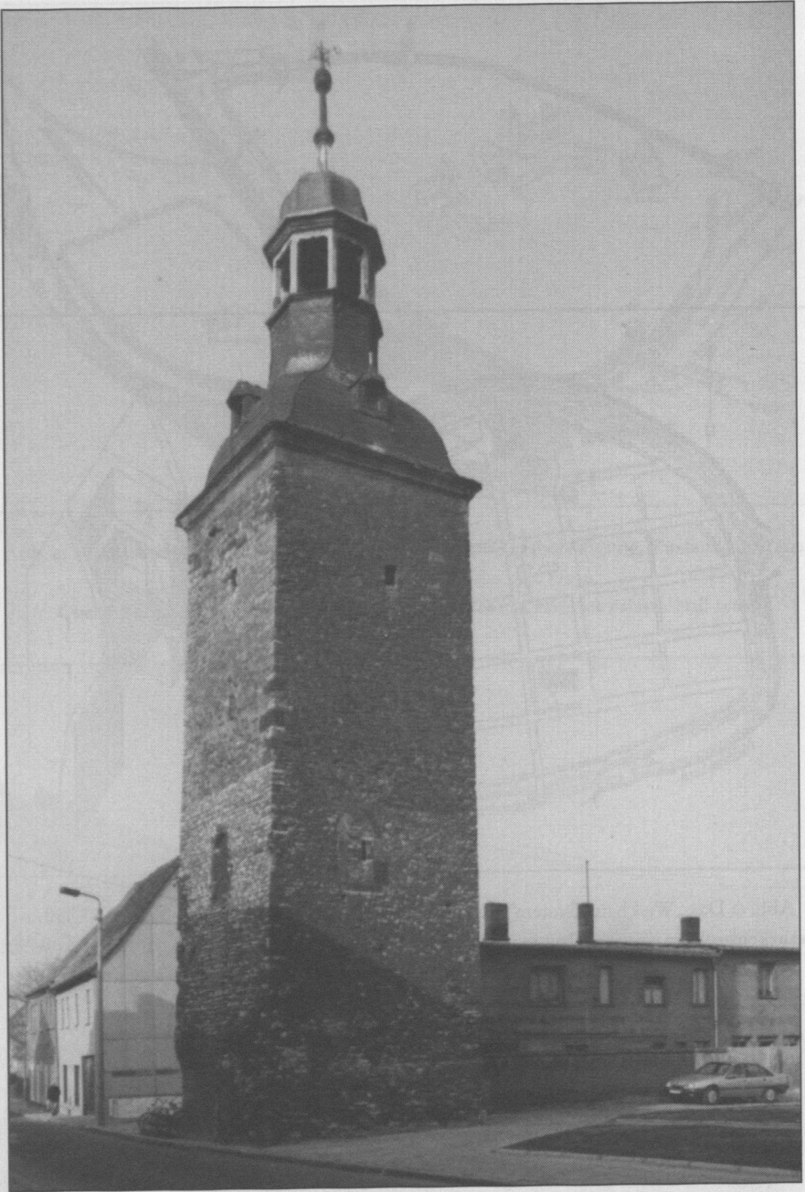
Abb. 7: Köthen (Sachsen-Anhalt), Turm neben dem „Magdeburger Tor“, wohl um 1300 Bergfriedartige Türme, hinter der Mauer neben dem (fast immer zerstörten) Tor stehend, sind in den meist kleineren Städte dieser Region häufig.
