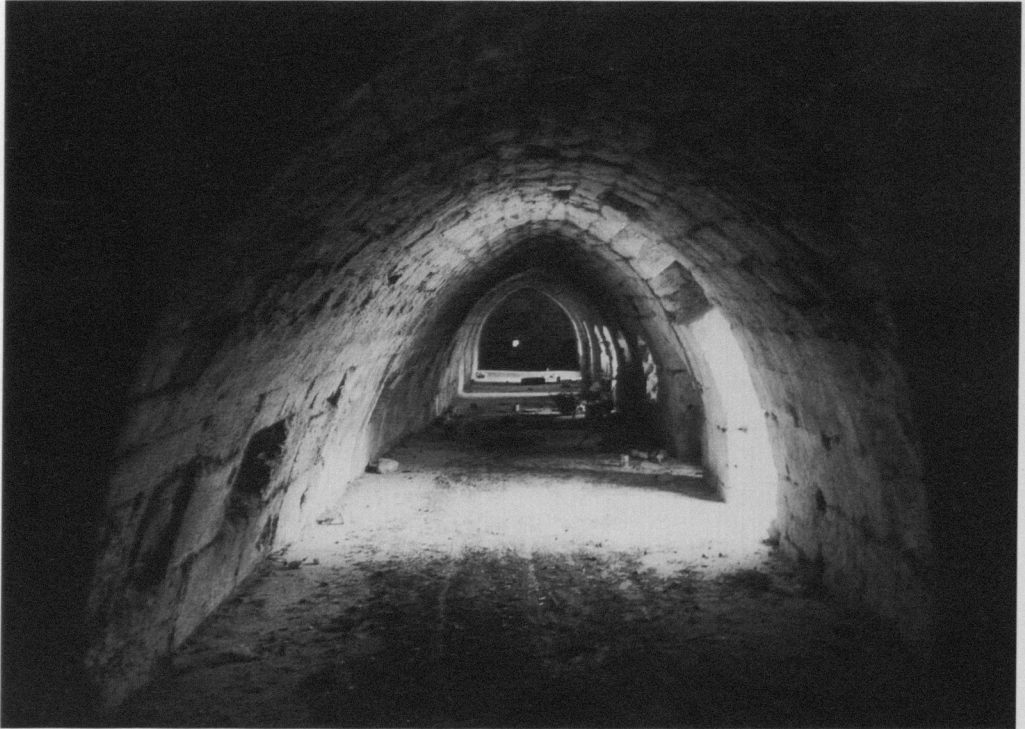
a) Das Innere des Ostflügels gegen Süden. Rechts die zahlreichen Pforten und Öffnungen zum Hof (1988).
