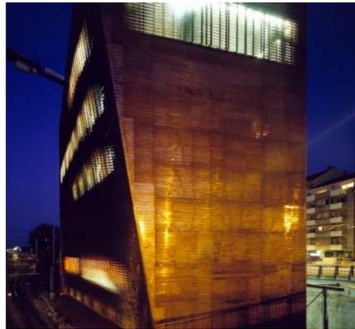
Abb. 3 | SBB Stellwerk 4, Auf dem Wolf, Basel. Das Stellwerk mit seiner Ummantelung aus getreppten Kupferbändern wirkt bewegt, so wie die vorbei fahrenden Züge. © Spiluttini
