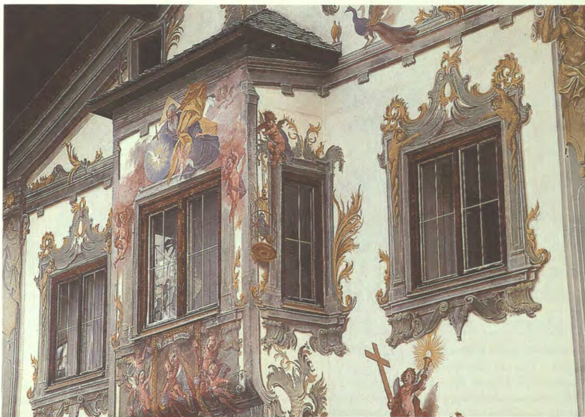
43 Fassadenmalerei des Zeillerhauses, um 1755, Reutte
