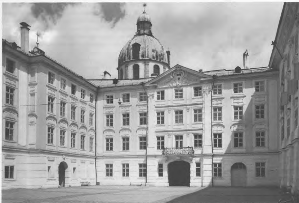
14 N. Pacassi u. a., Hoffassade der Hofburg, 1766–1770, Innsbruck
