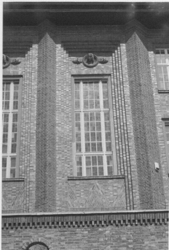
16. Lębork, szkoła przy ul. Dygasińskiego 14, Mohr & Weidner, 1926–1929. Fot. I. Grzeziuk-Olszewska
