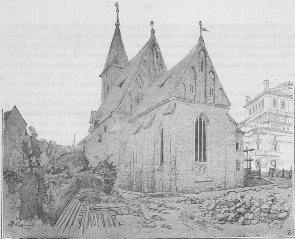
Fig. 1. Widok zewnętrzny kościoła św. Krzyża podczas restauracji.
