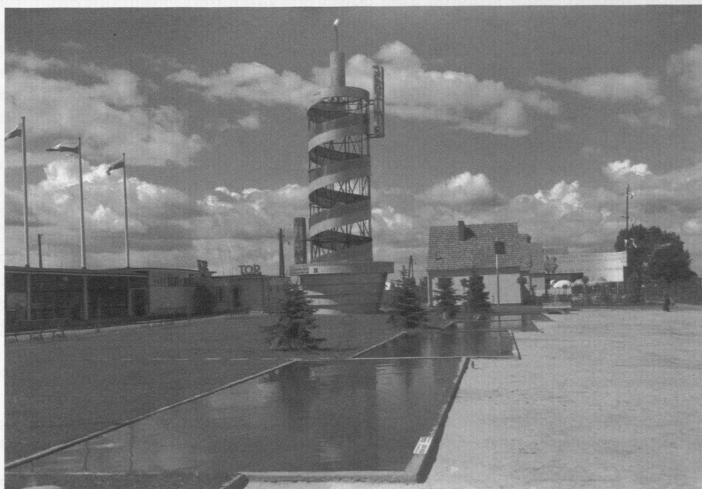
8. C. Olszewski, Tereny Wystawy Budowlano-Mieszkaniowej BGK na Kole w Warszawie , 1935 lub po 1935, reprint z negatywu, neg. IS PAN
