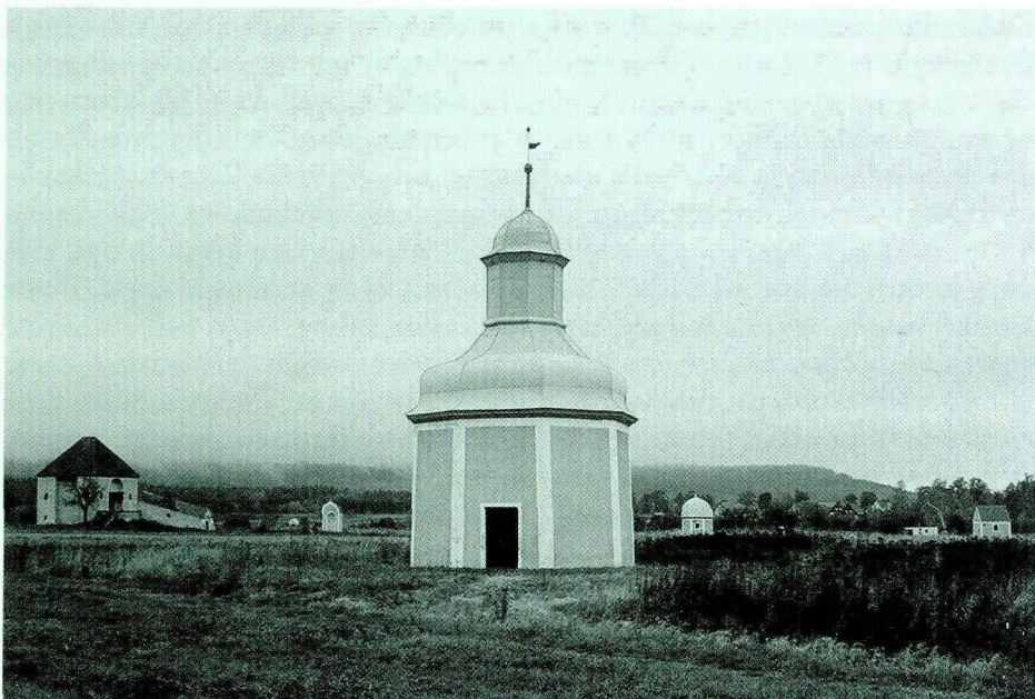
131. Kaplice Kalwarii w Krzeszowie, 1703–1722
