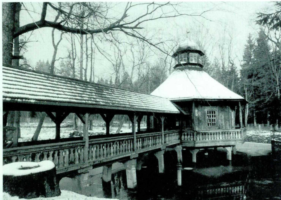
1. Betlejem, pavilion on the water, general view 1. Betlejem, pawilon na wodzie – widok ogólny
