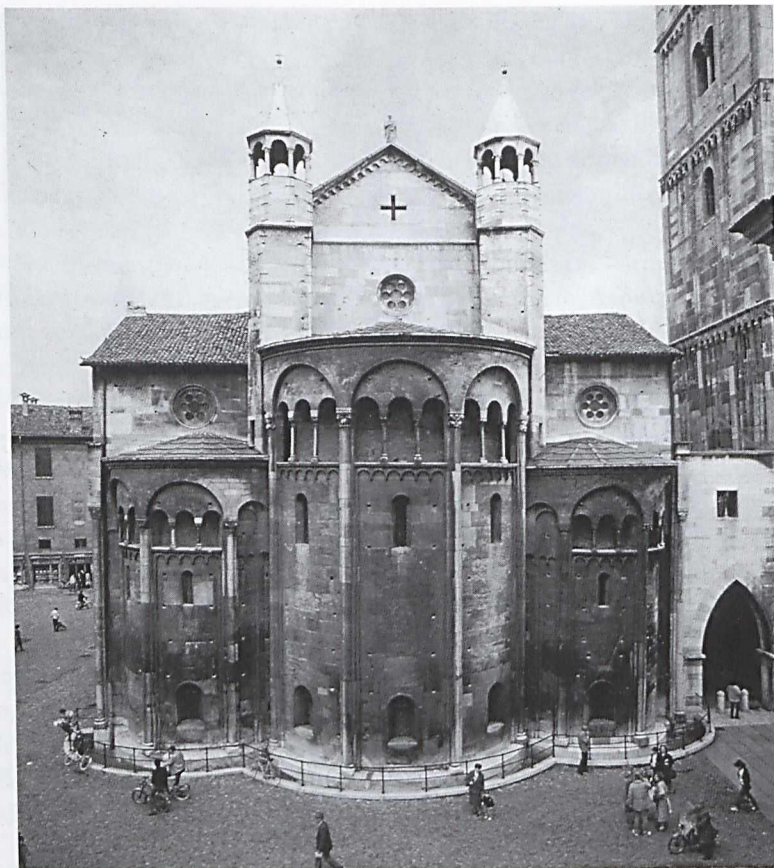
12. Modena, Dom, die Apsiden
