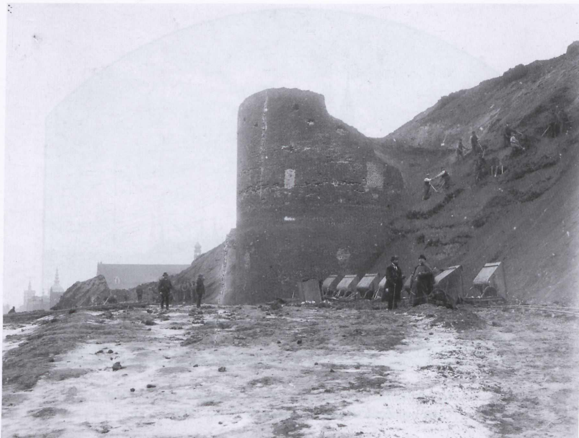
17. Rozbiórka obwałowań w okolicach Nowej Wieży w Gdańsku, fot. w zbiorach BG PAN
