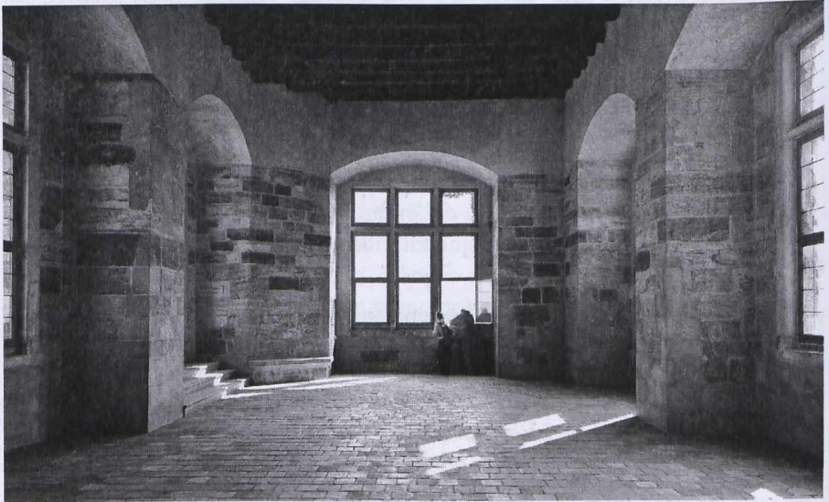
Abb. 9: Prag, Königsburg, Herrentafelstube im obersten Geschoss des Ludwigsbaus von 1510, heutiger Zustand nach dem Großbrand 1541 (© HOPPE 2008).
