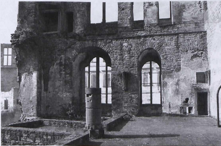
Abb. 12: Heidelberg, Ruine der Herrentafelstube im sog. Bibliotheksbaus, um 1520; Blick auf die Reste der West- und Nordwand, hinter den Fenstern war ursprünglich die Stadt und der Neckar sichtbar, der heutige Gebäuderiegel ist jünger (© HOPPE 2003).
