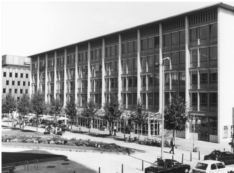
Abb. 163: O 2, Fassade zum Paradeplatz, 1997
