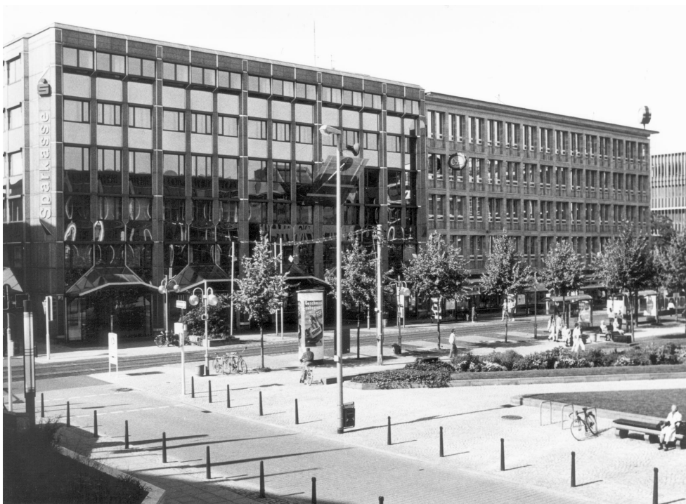
Abb. 161: D 1, Fassaden zum Paradeplatz, 1997
