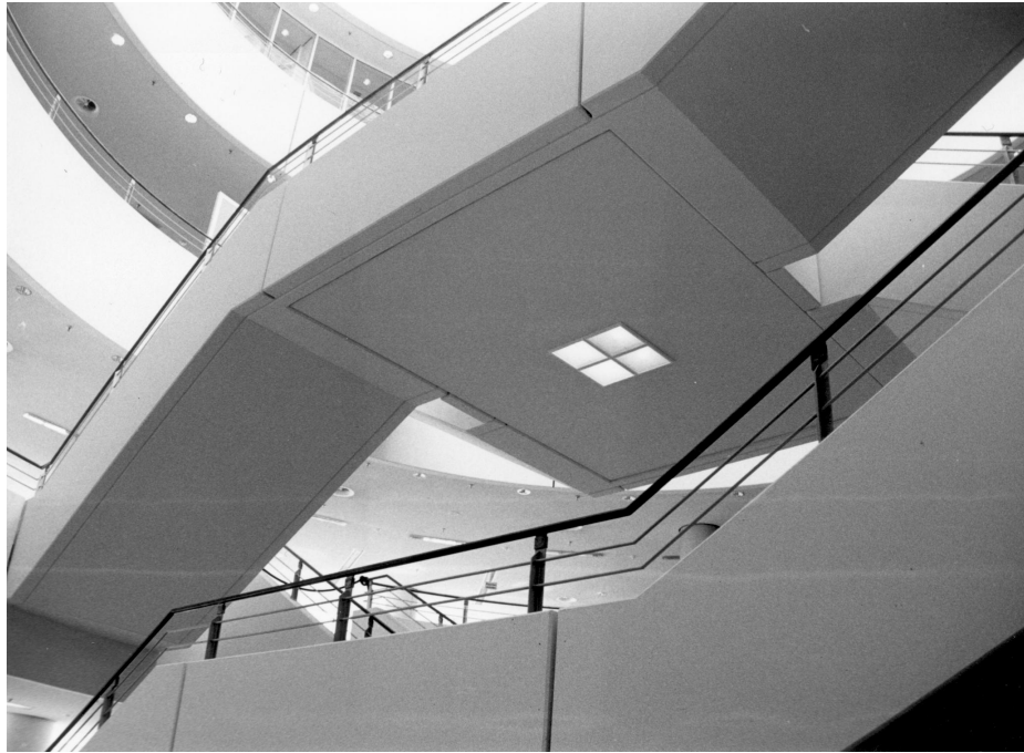
Abb. 138: Treppenanlage in der Rotunde
