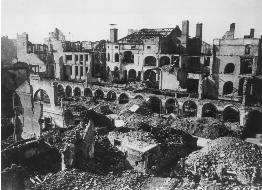
Abb. 25: Kriegszerstörtes Kaufhaus von Osten 1945
