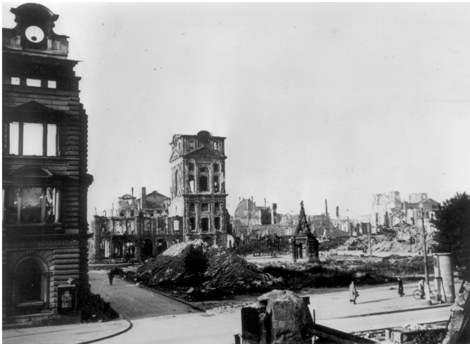
Abb. 26: Kriegszerstörtes Kaufhaus von den Planken 1945
