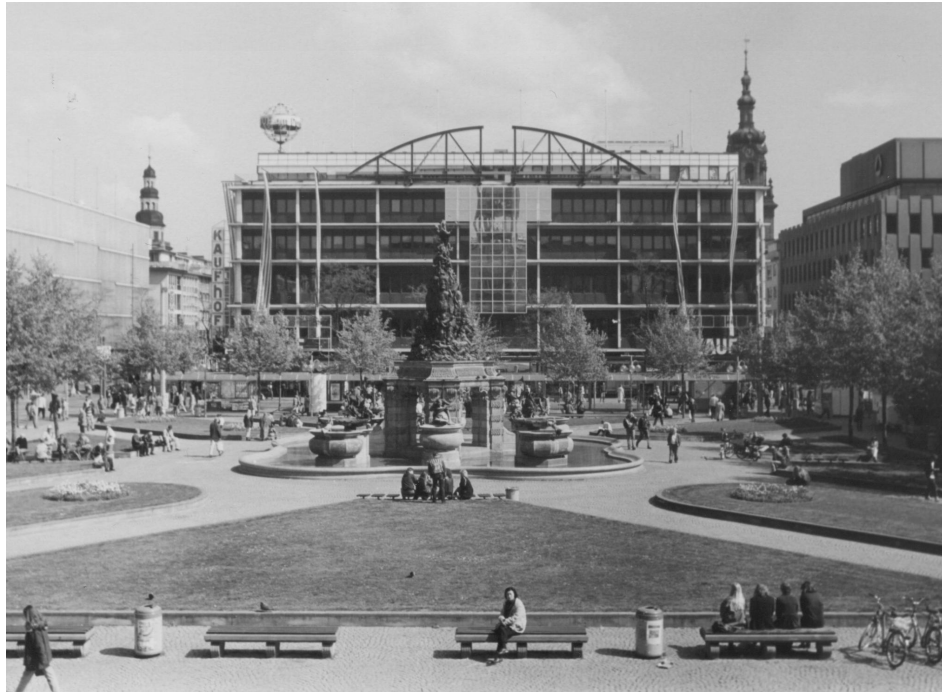
Abb. 162: P 1, Fassade zum Paradeplatz, 1997
