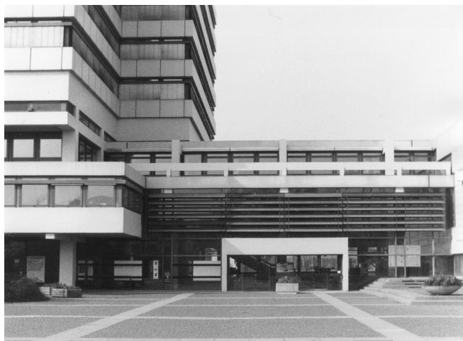
Abb. 57: Eingang des Rathauses Kaiserslautern
