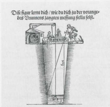
Abb. 8 Messung der Brunntiefe mit dem Quadranten (nach Apian: Instrument Buch, 1533, III.12)
