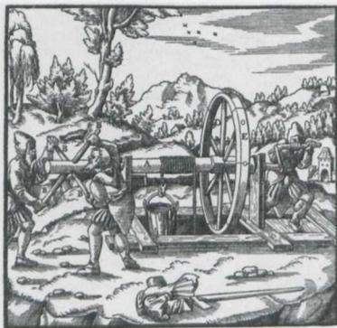
Abb. 4 Haspelwinde (nach Agricola: De re metallica, 1556, VI)
