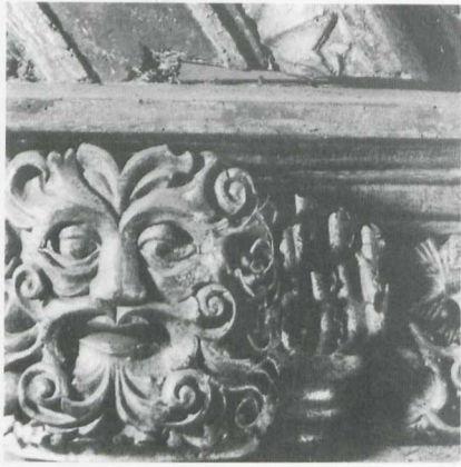
86 Abbildung 5. Ausgebrochene Sägekante am rechten Giebelansatz. © Archiv H. Hubach.
