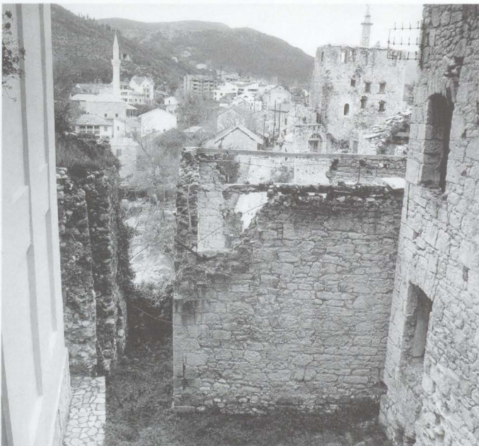
Abb. 2: Mostar, Blick vom Turm Hercegusa auf die westliche Brückenseite. (G. U. Großmann, Nürnberg)
