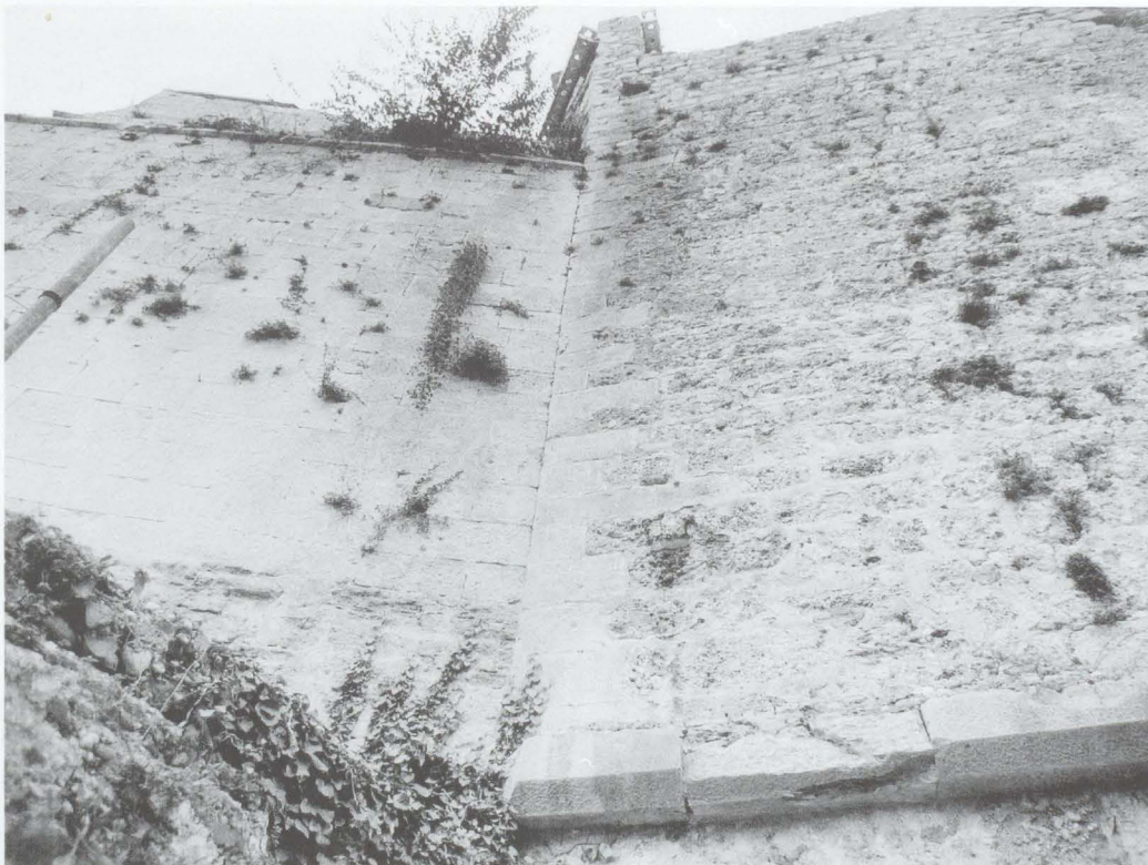
Abb. 8: Mostar, westlicher Brückenkopf, Tor und Baufuge darunter; links ehemaliger Graben vor dem Tor. (G. U. Großmann, Nürnberg)
