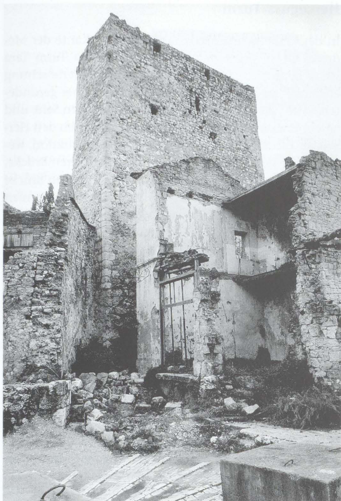
Abb. 11: Mostar, Turm Tara auf der östlichen Seite und Ringmauer. (G. U. Großmann, Nürnberg)
