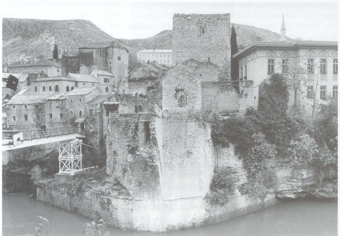
Abb. 15: Mostar, östliche Brückenseite, Gesamtanlage, rechts die Medrese und der efeuerverdeckte kleine Turm Hercegusa. (G. U. Großmann, Nürnberg)
