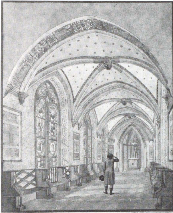
10. Innenansicht der Kartäuserkirche im Schloßpark von Hohenheim. Aus: Ansichten des herzoglich Württembergischen Landsitzes Hohenheim , Nürnberg 1785–1800 von Victor Heideloff
