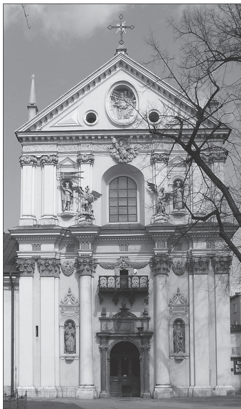
233. Kraków, kościół Widytek, fasada
