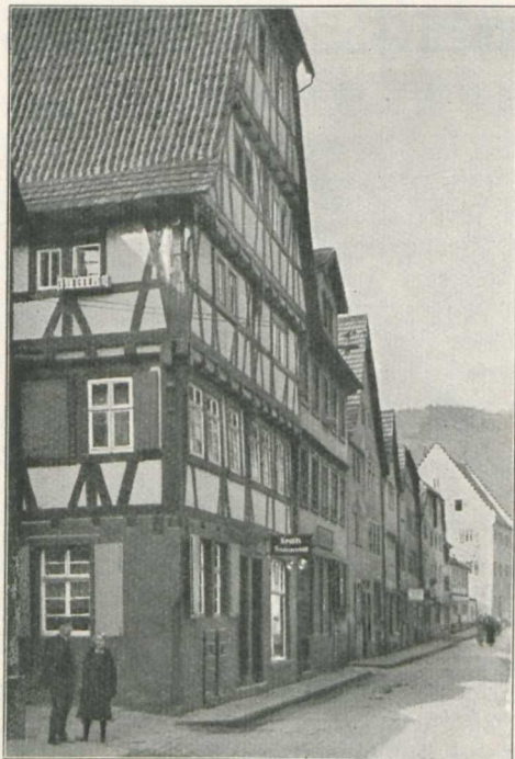
5. Haus Kraft in der Kellereistraße
