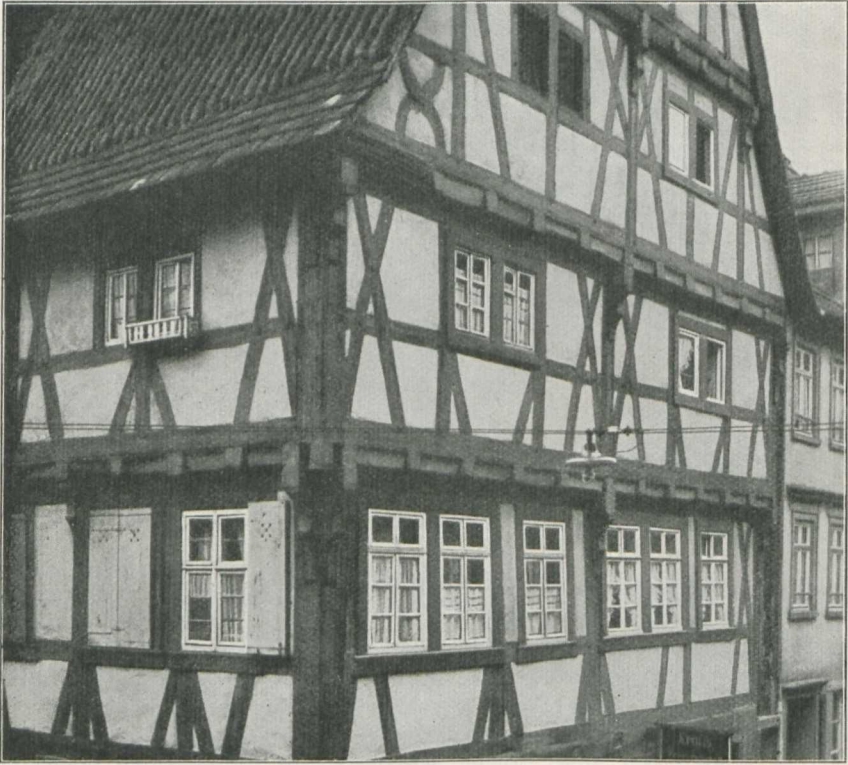
4. Haus Kraft in Eberbach
