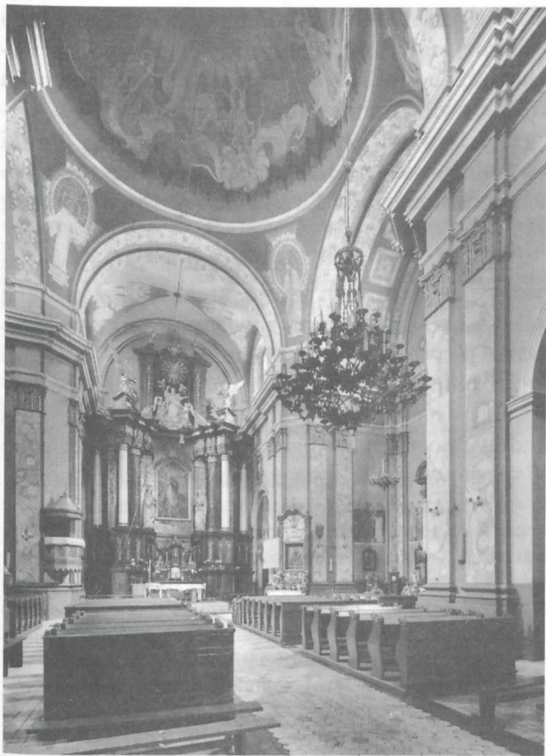
Ryc. 25. Sieniawa. Kościół dominikanów obserwantów — widok wnętrza w kierunku ołtarza głównego. Arch. Jan Spazzio, rozpoczęty 1719. Fot. Witalis Wolny
