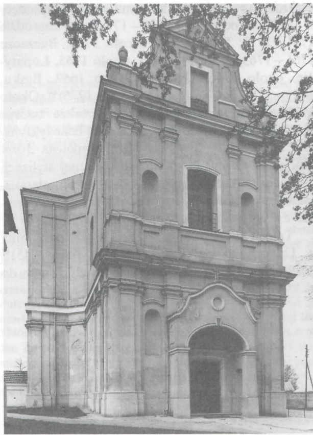
Ryc. 26. Sieniawa. Kościół dominikanów obserwantów — fasada. Arch. Jan Spazzio, rozpoczęty 1719. Fot. Witalis Wolny
