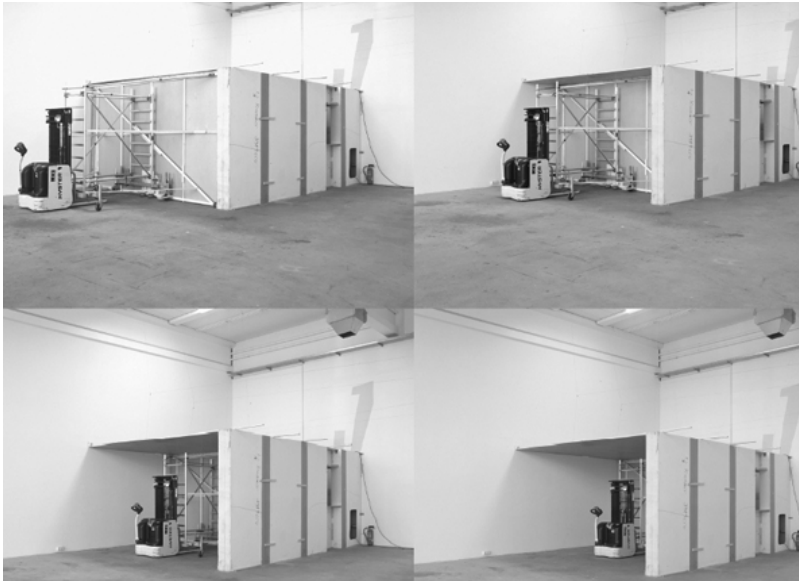
Abb. 297 wie 296 (die Fotografien zeigen in vier Schritten wie der Gabelstapler die Wand bewegt)
