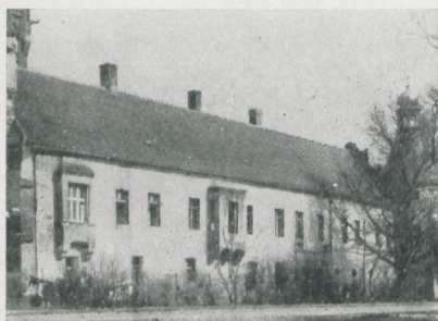
Il. 4. Łąka Prudnicka, pd. skrzydło zamku. (Fot. T. Chrzanowski)
