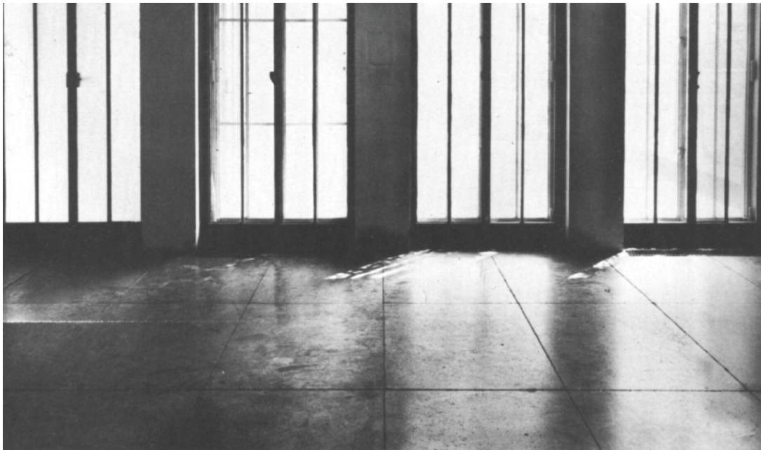
Abb. 5 Palais Stenborough, ausgerichtete Fliesenfugen im Fußboden des Speisezimmers
