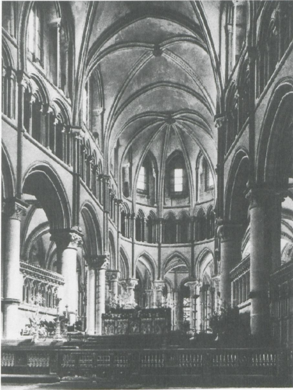
6 Canterbury, Kathedrale; Innenansicht des Chores.
