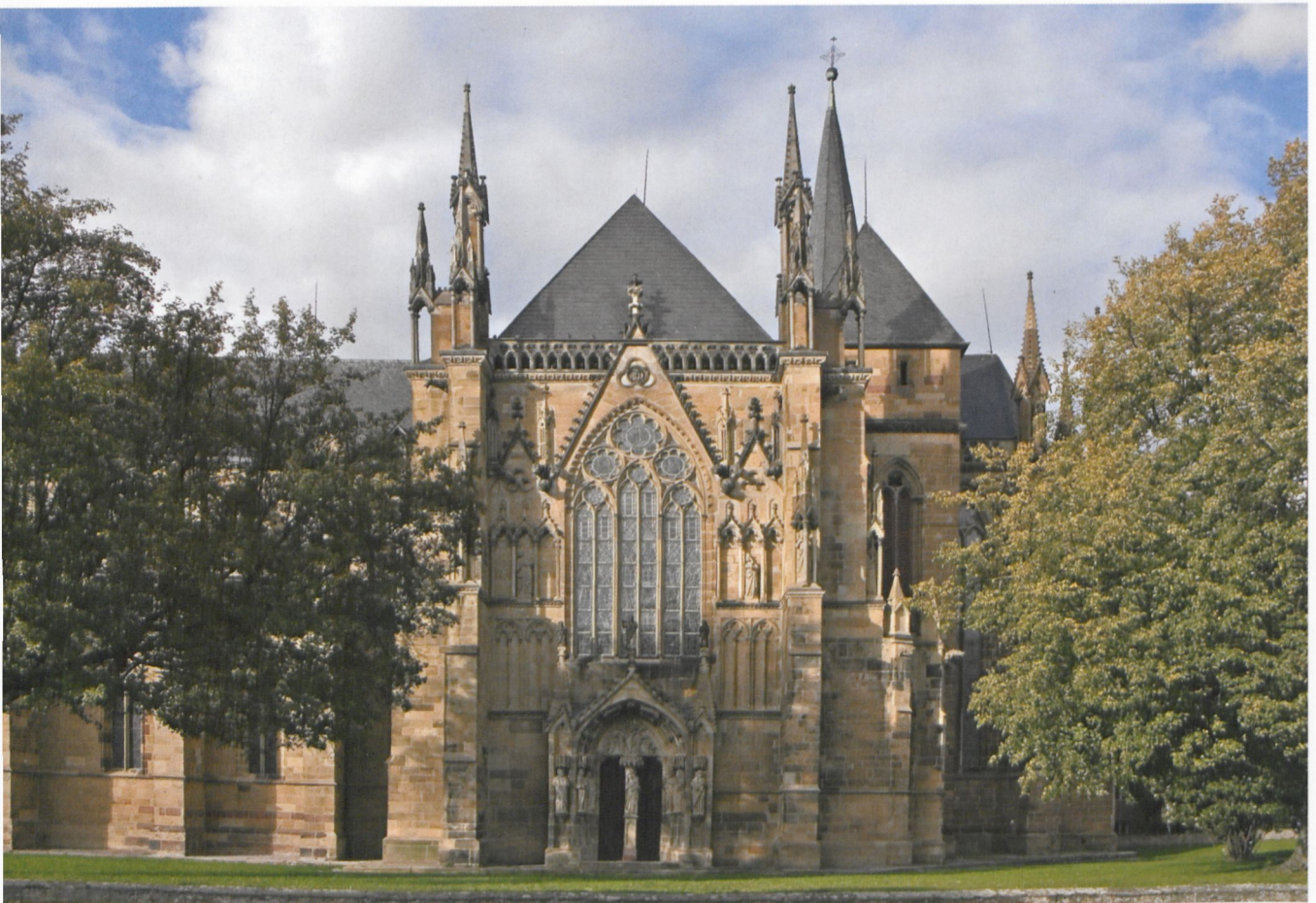
5 Wimpfen, ehem. Ritterstiftskirche, St. Peter im Tal, Südquerhausfassade, 1260–1279
