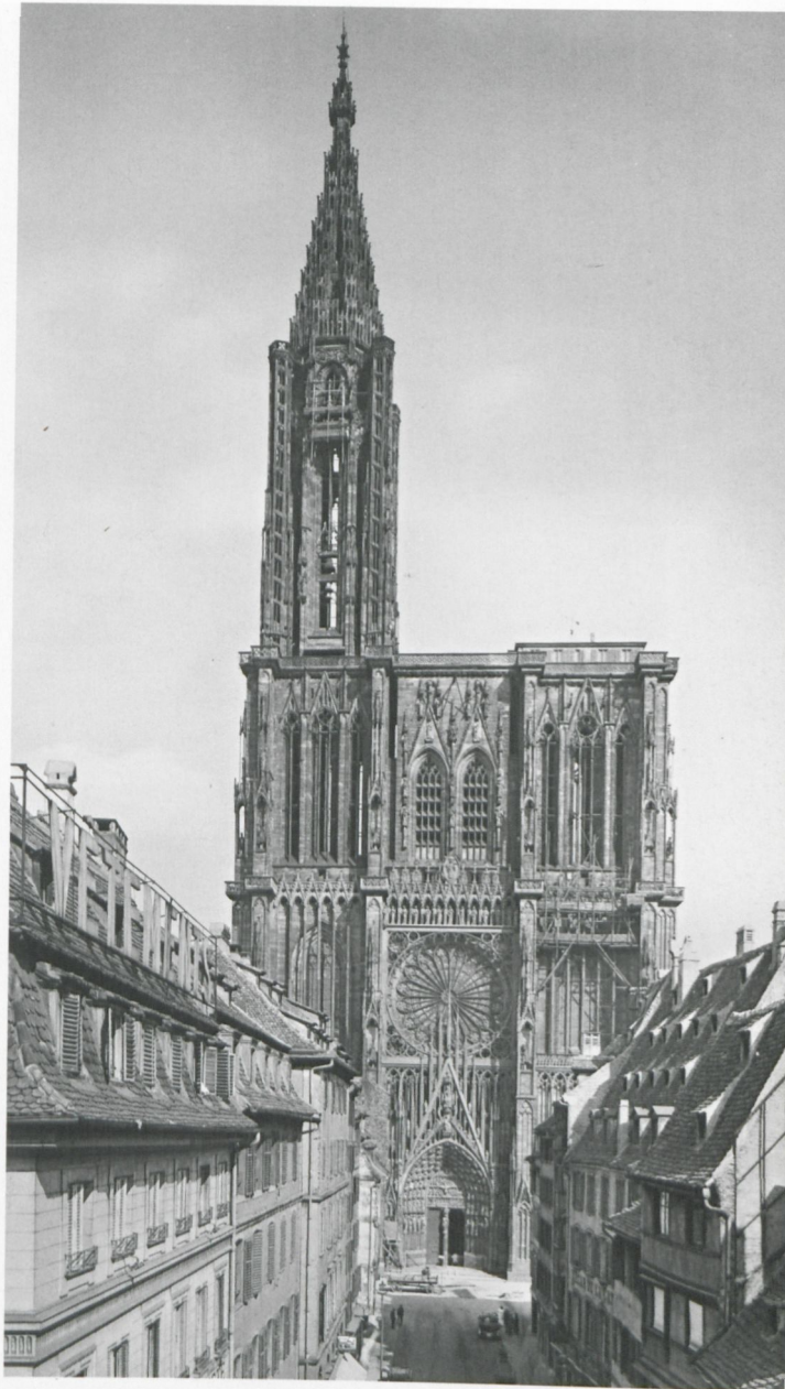
18 Straßburg, Münster, Westfassade, 1277–1439
