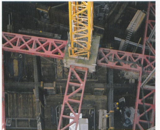
Abb. 4: Baukran im Innenhof
