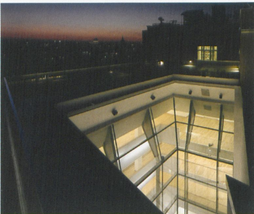
Abb. 3: Blick in den Innenhof des Neubaus
