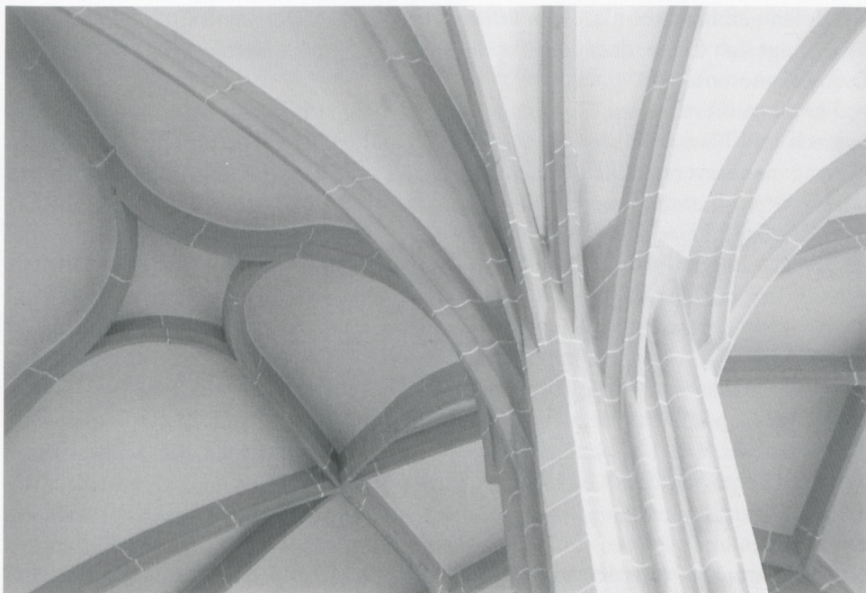
Abb. 3: Görlitz, Peterskirche, Gewölbeanfänger (Stefan Bürger).
