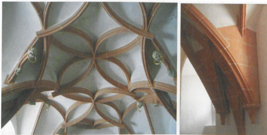
Abb. 12 und 13: Gewölbe und Gewölbeanfänger in der Alten Sakristei der Annenkirche [Fotos: Stefan Bürger].
