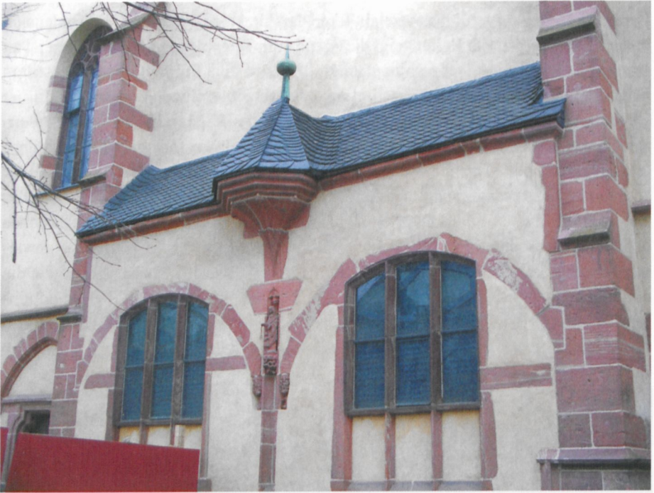
Abb. 18: St. Leonhard Frankfurt a. M., Rest der ehem. Außenkanzel für Heilumsweisungen, erstes Viertel des 16. Jahrhunderts [Foto: Stefan Bürger].
