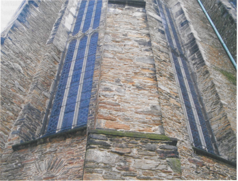
Abb. 3: Annenkirche Annaberg, aufgehendes Mauerwerk am Chor (erst im oberen Bereich wurden die Pfeilerkanten und Fenstergewände mit Werksteinen ausgeführt) [Foto: Stefan Bürger].
