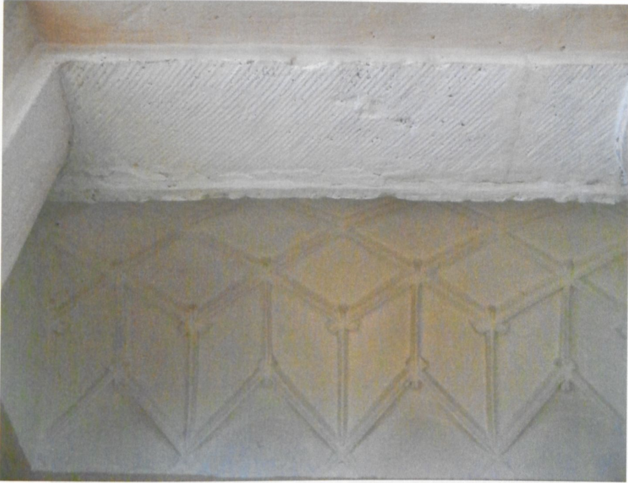
Abb. 4: Annenkirche Annaberg, Ziergewölbe des Sakristeischrankes von 1507 [Foto: Stefan Bürger].
