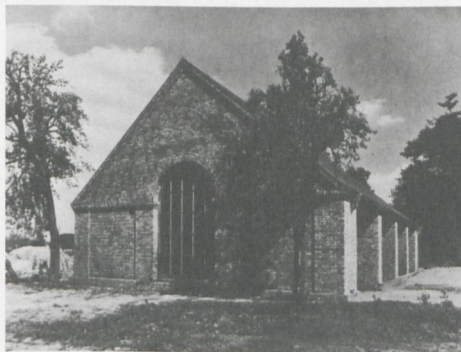
Friedrich Tamms, Ateliereubau Jäckelsbruch 1940
