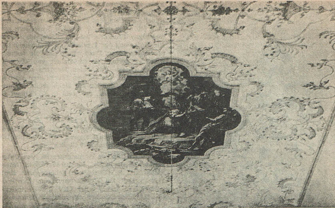
Bild 4. St. Katharina: Stuck an der Decke
