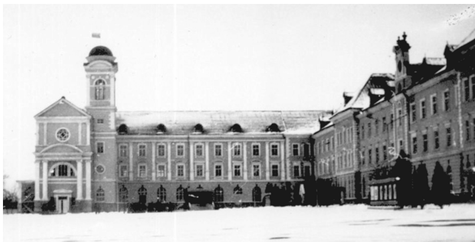
66. Nowe skrzydło i kaplica, ok. 1990 r. Widok od północnego zachodu
