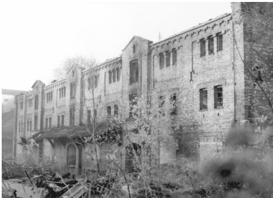
90. Spichlerz Galicyjskiego Banku Handlu i Przemysłu przy ul. Warszawskiej 19 w Krakowie (nie istnieje), projektu Antoniego Łuszczkiewicza, 1869–1870 r.
