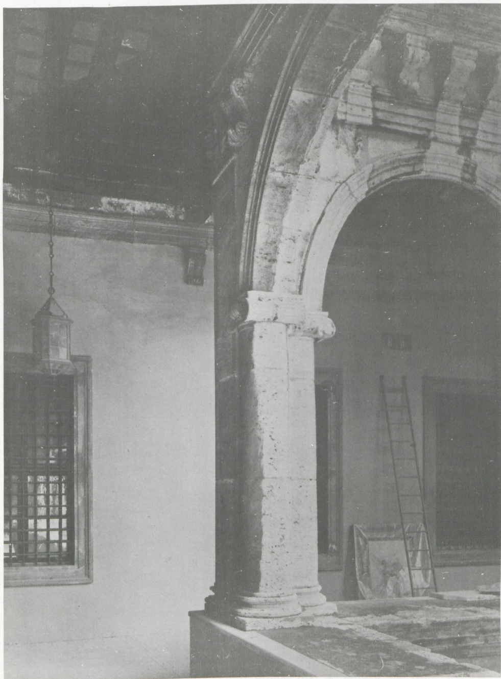
Fig. 3 - Roma, Palazzetto Venezia, chiostro, loggia superiore, stato odierno.
