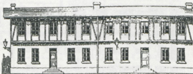
Abb. 4: Essen, Arbeiterkolonie Westend, 1863, Häuserzeile aus dem ersten Bauabschnitt
