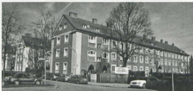
Abb. 13: München, Arbeitersiedlung Alte Heide, 1918-29, Häuserzeilen
