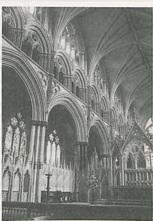
ABB. 3: LINCOLN, KATHEDRALE, ENGELSCHOR, MITTELSCHIFF, WANDAUFBAU
