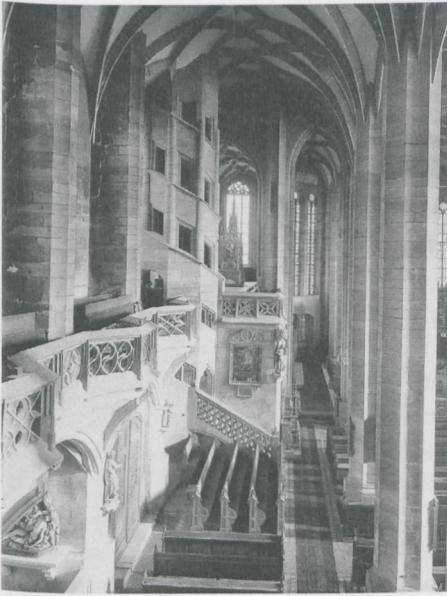
Abb. 20: St. Marien Zwickau, Langhaus mit umlaufender Empore und Wendeltreppen
