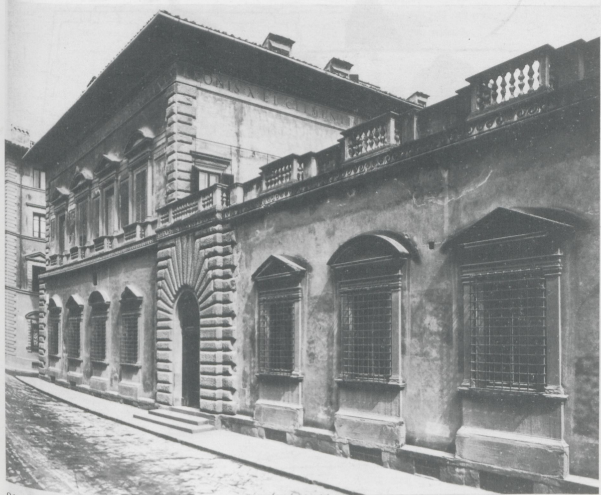
91 - La facciata principale di Palazzo Pandolfini a Firenze
