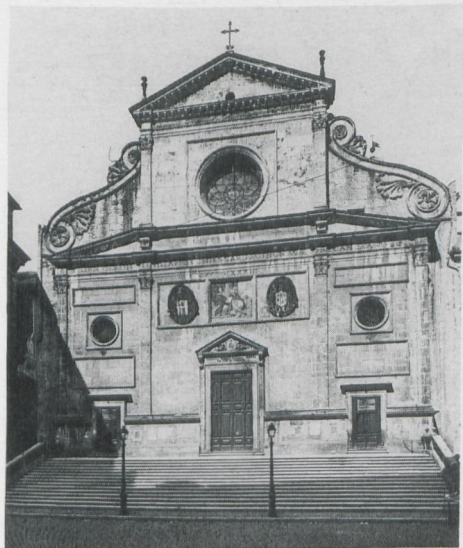
fig.6 - Roma. Facciata di S.Agostino.
