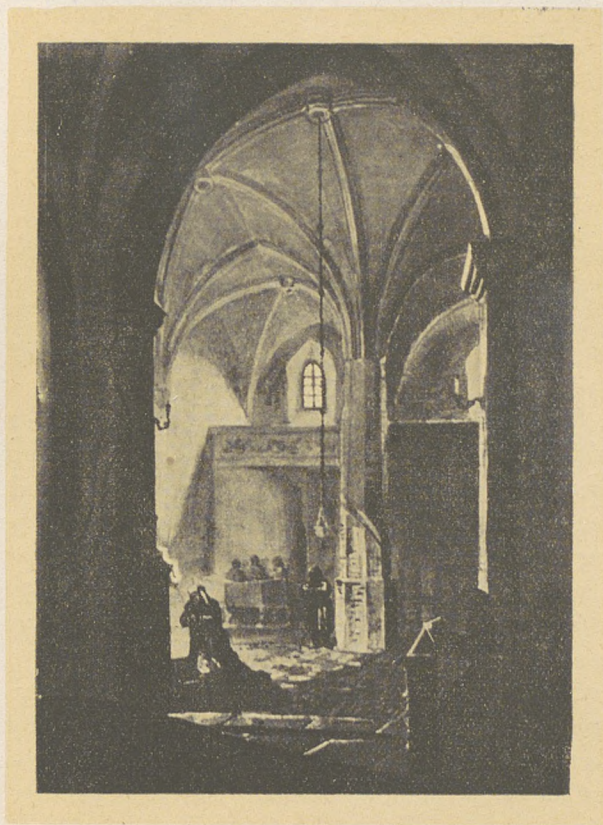
65. Wnętrze kościoła św. Trójcy wg. dawnej akwareli.
