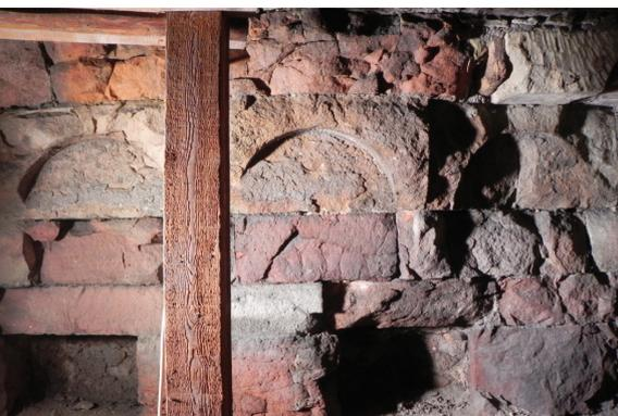
Abb. 11: Stark beschädigter Rundbogenfries unter dem Dach des Ägidienchörleins
