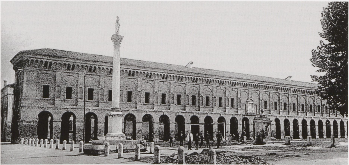
4 Sabbioneta, Palazzo del Giardino, Antikengalerie. Fotografie vor der Versetzung der Pallas-Athene-Säule auf die Platzmitte, 1931
