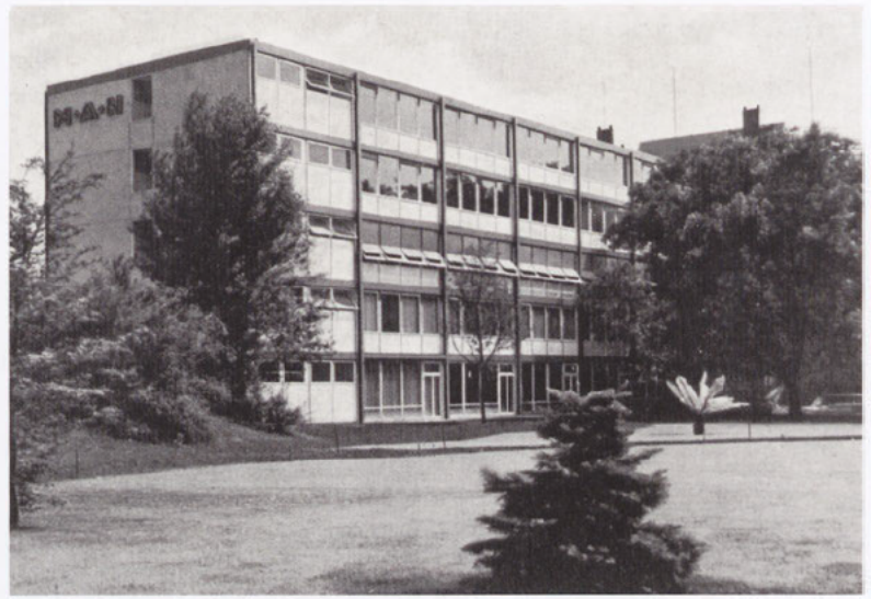
5 Klaus Flesche, MAN-Verwaltungsgebäude, Gustavsburg, 1955 5 Klaus Flesche, MAN Administrative Building, Gustavsburg, 1955
