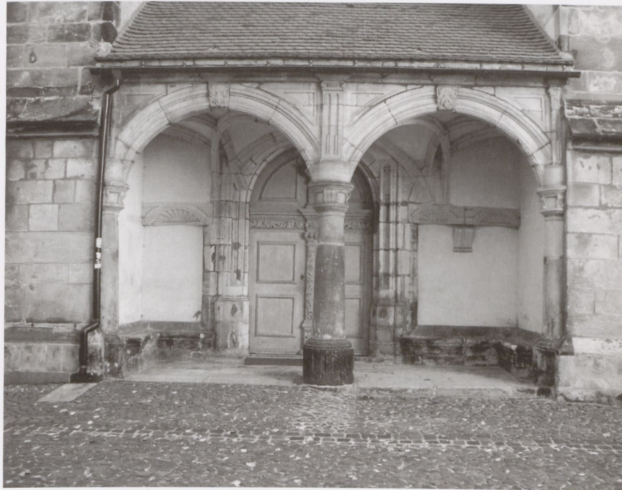
15 Görlitz, Peterskirche, Nordportal, 1543
