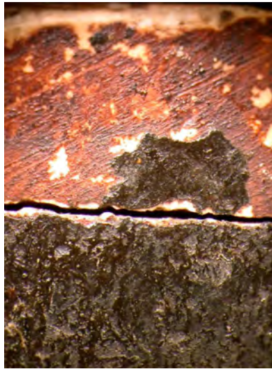
Abb. 4.2.2 / 7 (B_VI_03) Vierkanteleiste: offene Fuge Brett VI
