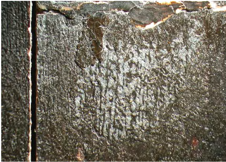
Abb. 4.2.3 / 21 (B_II_01) Malschichttrunzelung; 2. Bildphase (unter Bleiweiß-Kreide-Kittung)
