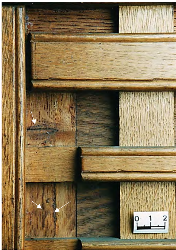
Abb. 3.2.4 / 13 Rückseite von Brett VII, Astlocheinschluss und Holzriss
