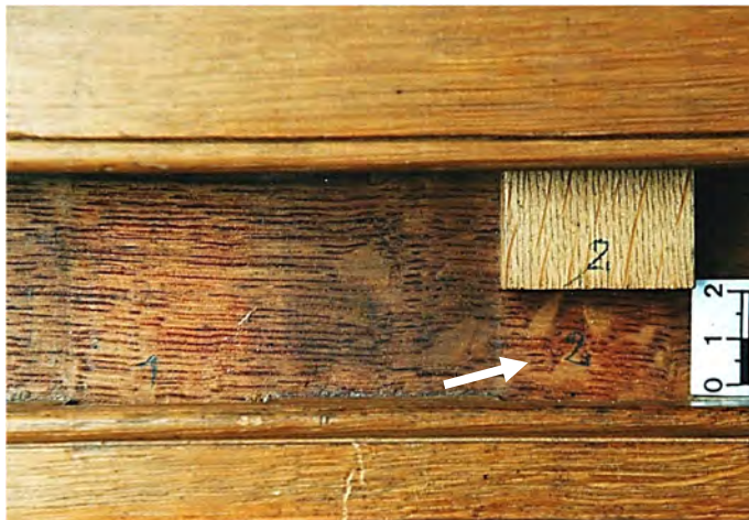
Abb. 3.2.4 / 20 Parkettierung mit Nummerierungen auf und unter den Einschubleisten
