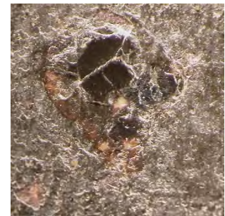
Abb. 3.2.6 / 14 (B_VII_07) Stoßschaden in Bildphase 2 ausgebessert in Bildphase 3
