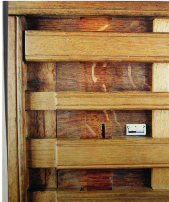
Abb. 3.2.4 / 7 Beim rückseitigen Dünnen des Bildträgers aufgeschnittener Dübellochverlauf an der Fuge zwischen Brett I und II
