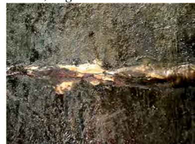
Abb. 7.1 / 7 (B_III/1_04) Ärmel links, Fuge zwischen Brett III/1 und /2
