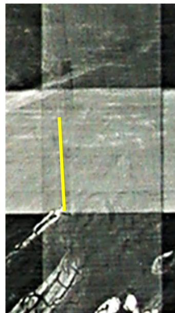
Abb. 3.1.3 / 6 c (Detail zu Abb. 3.1.3 / 6b) Die Bohrkanäle der Fugensicherung zwischen Brett II und Brett III
