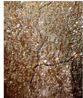
Abb. 3.2.5 / 5 (B_III_02) Hintergrundfarbton der 1. Bildphase, in den Schwundrißtiefen ist die dunkle Imprimitur darunter zu sehen
