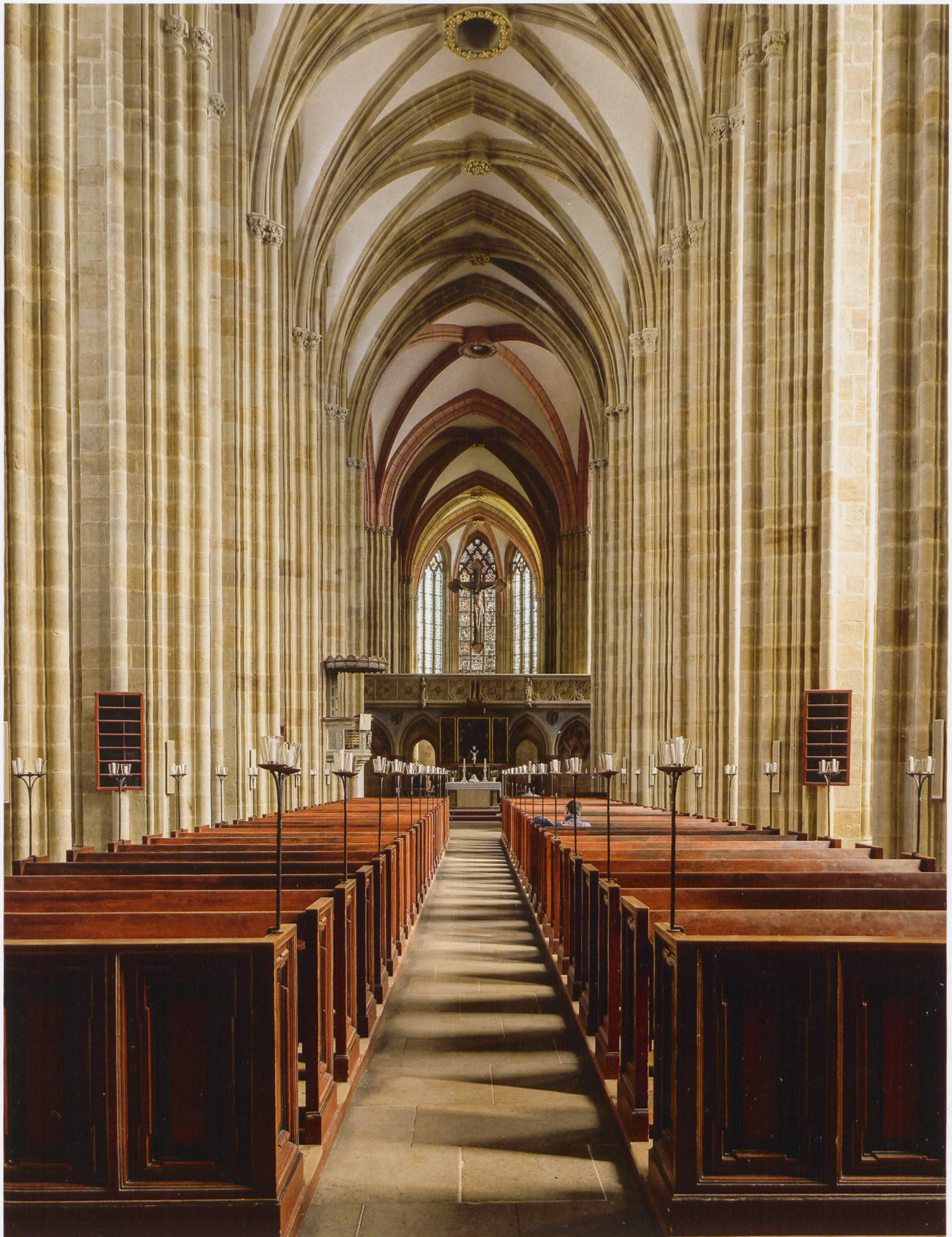
Abb. 3 | Dom zu Meißen, Mittelschiff mit kräftig gegliederten Pfeilern, die wie in Basiliken die Seitenschiffe stark abgrenzen
