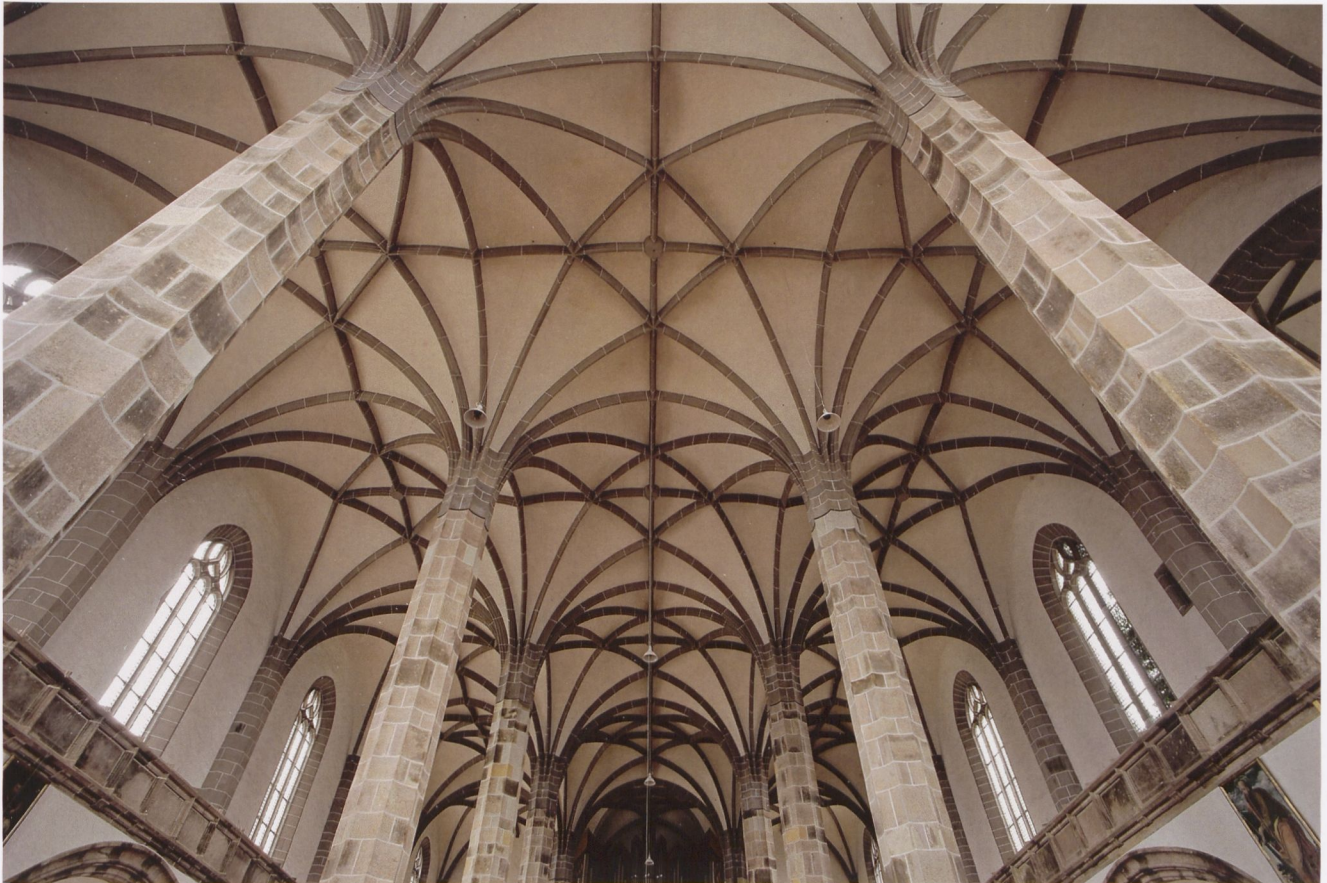
Abb. 1 | Ev. Wolfgangskirche in Schneeberg, Gewölbe
