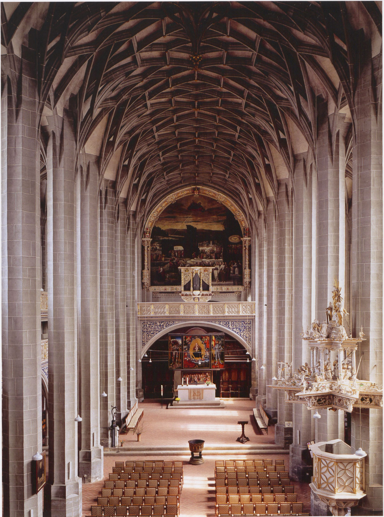
Abb. 5 | Marktkirche in Halle (Saale), Mittelschiff, Gewölbe mit hängendem Schlussstein im Bereich der Kanzel
