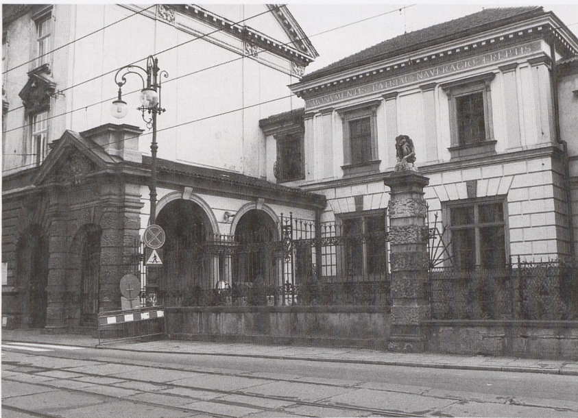
5 Pavilion of the Emeryk Hutten Czapski Museum. Cracow. 1895-1897. Tadeusz Stryjeński and Józef Pokutyński. Photo: Adam Rzepecki.
