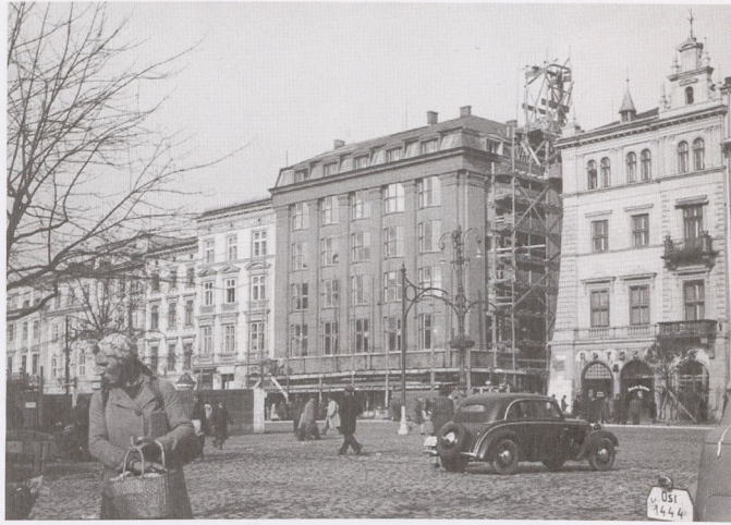
3: Krakau, Marktplatz mit dem Feniks-Gebäude im Umbau, 1942 (Foto Archiwum Państwowe Kraków).
